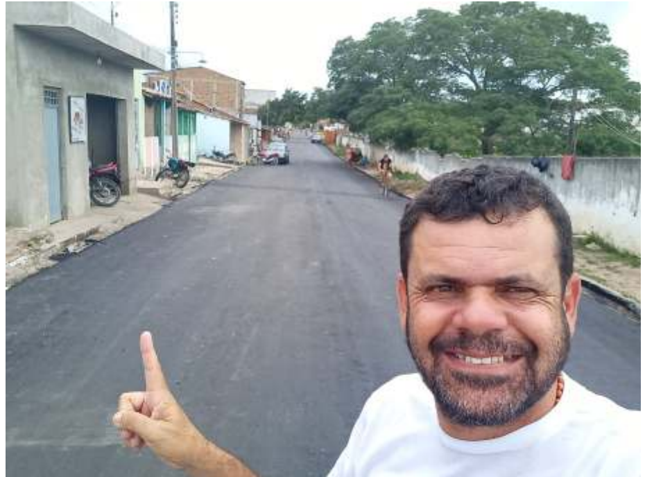
Prefeito Merson acompanhou pessoalmente as obras de construção do asfalto nas ruas do Centro
